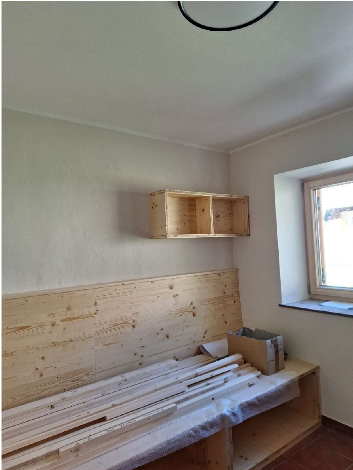
April 2026: Ein angenehmer Holzduft macht sich im Haus breit – die Tischlerei liefert und baut die Zimmereinrichtungen ein.
