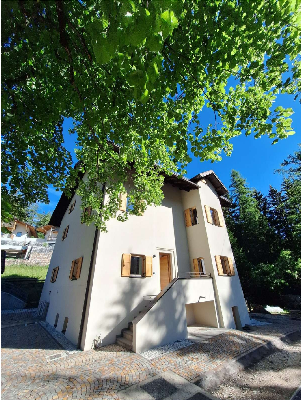
Juni 2026: Innen schon top und außen sogar schon fertig bepflastert.
