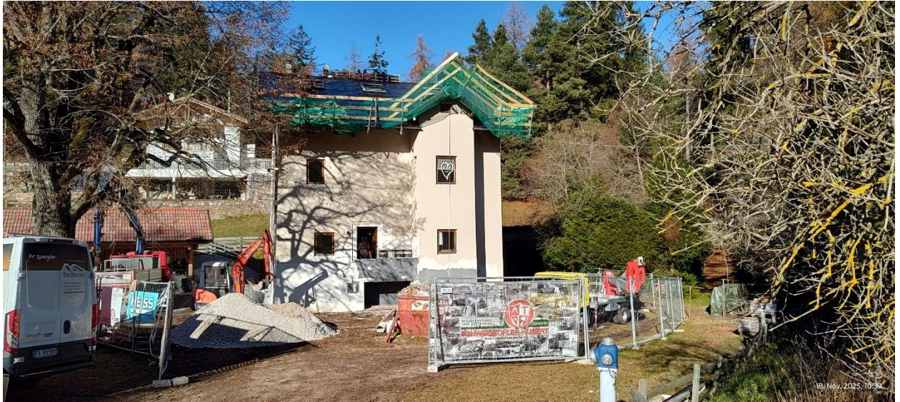
November 2025: Die neue Fassade wird gestrichen auch am Dach wird gearbeitet, bald wird die Photovoltaikanlage montiert werden.
