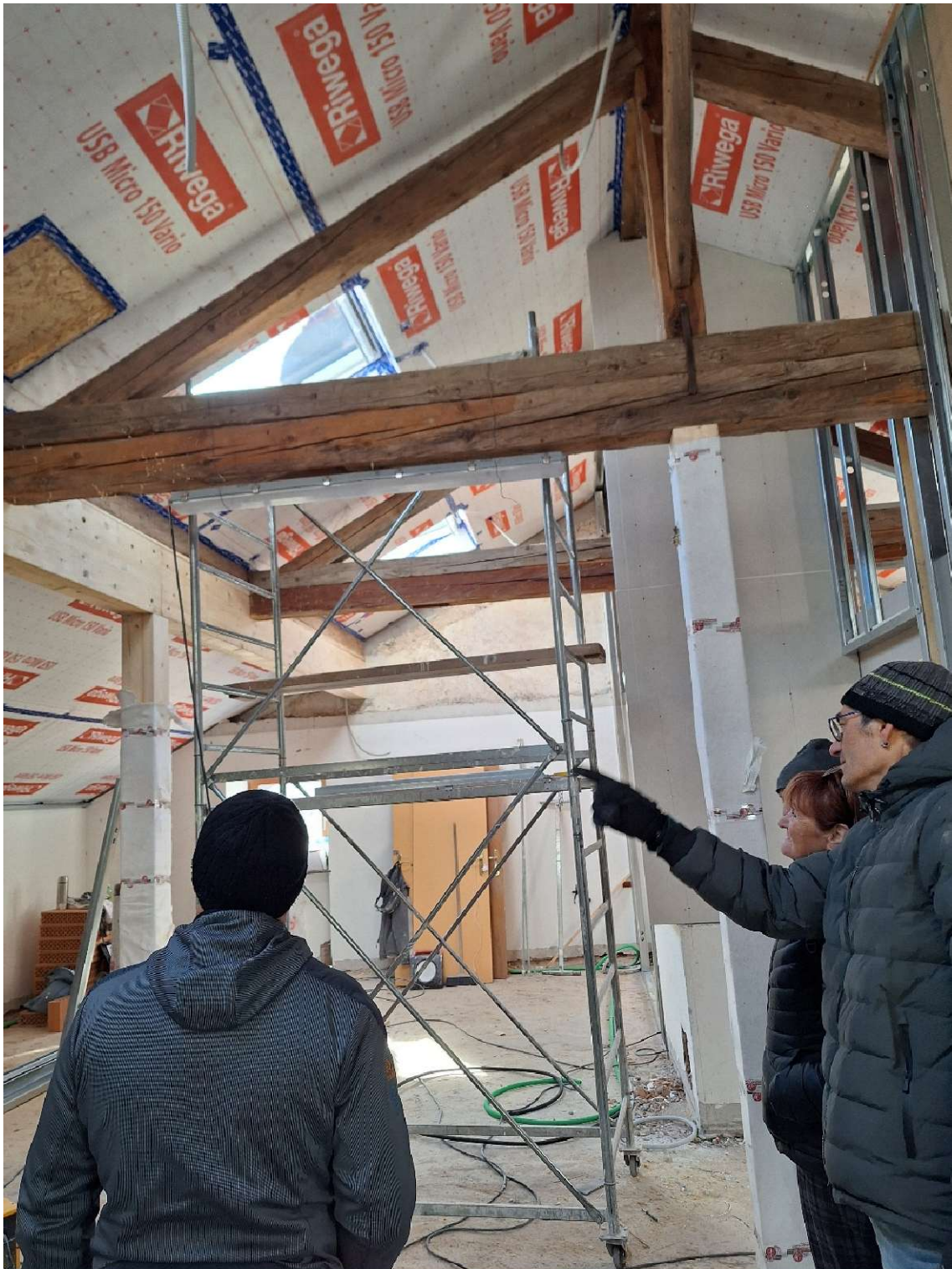
Lokalausgleich: Noch braucht es etwas Vorstellungskraft, aber schon jetzt wirkt das Unterdach wunderbar lichtdurchflutet.
