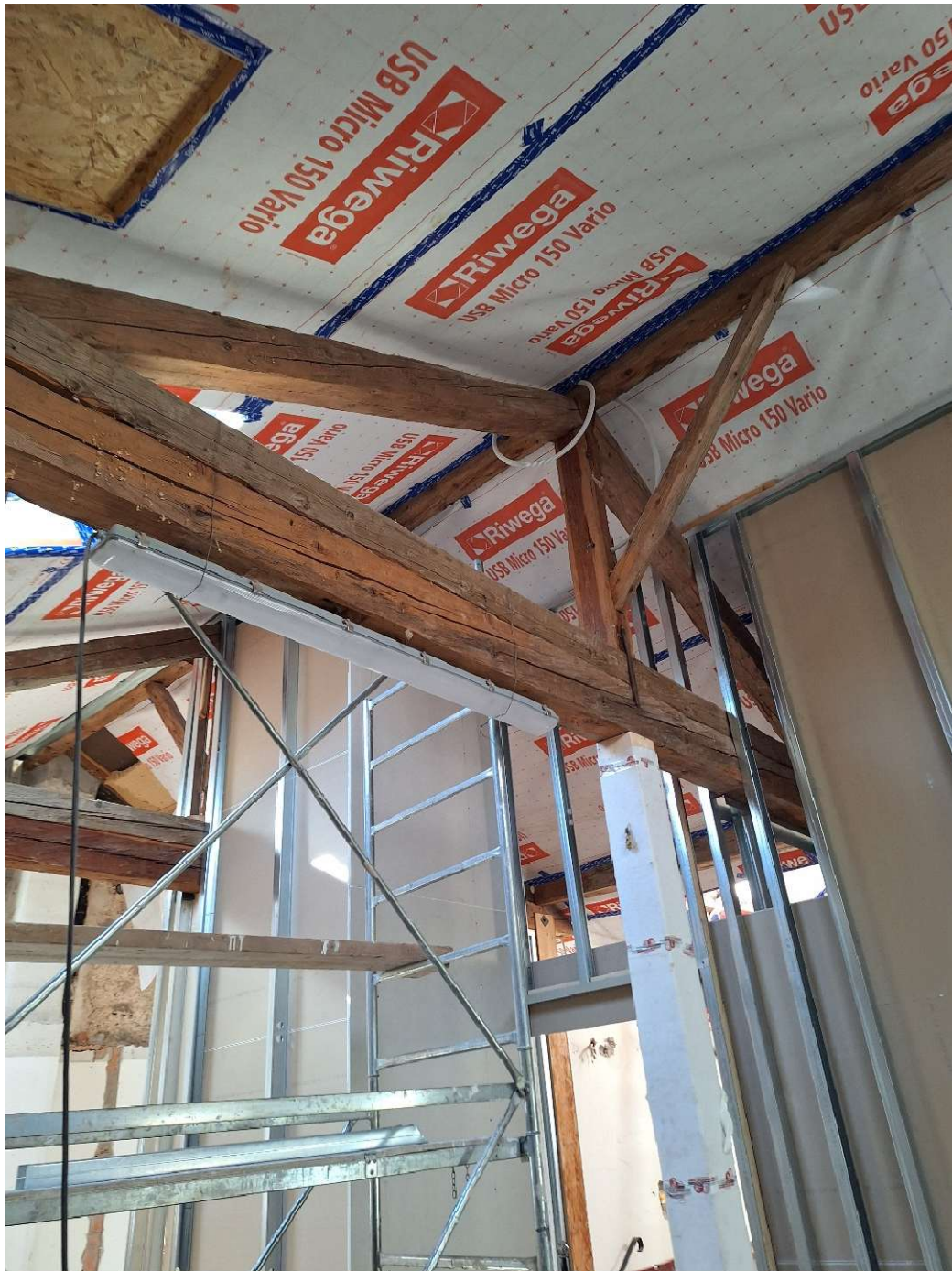
Licht, Luft und Raum für den Seminarraum im „Unterdach“.
